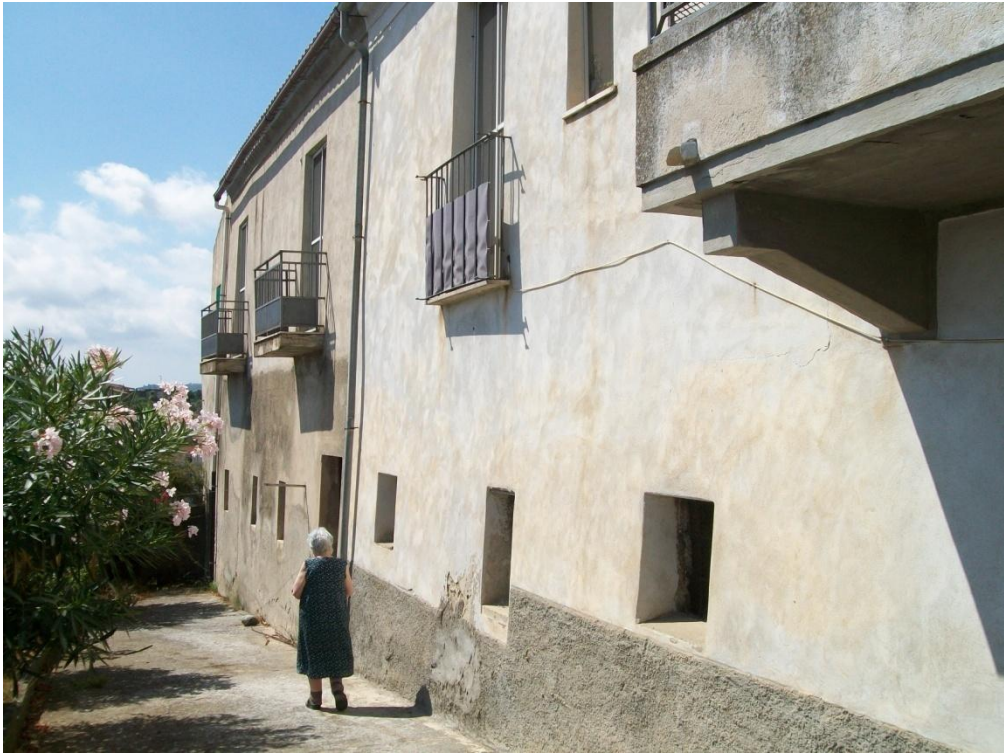
Un lato del convento di Santa Maria delle Grazie., di fronte alla strada. Nel piano terra i locali sono con le volte a botte e con le finestrelle come erano originariamente.
